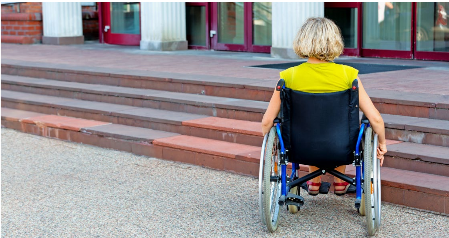
La liste des exigences à remplir pour que le cabinet dentaire soit facilement accessible est longue. Places de stationnement pour handicapés, chemin d'accès, enseigne du cabinet et sonnette ainsi que des installations sanitaires adaptées sont autant de critères décisifs.
