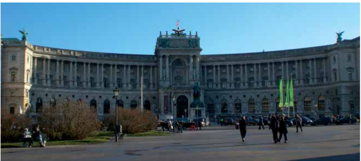
Wiener Hofburg: die historischen Räumlichkeiten der ehemaligen kaiserlichen Winterresidenz der Habsburger behielten ihren ursprünglichen Zustand und bilden heute den Rahmen für aussergewöhnliche Veranstaltungen.
