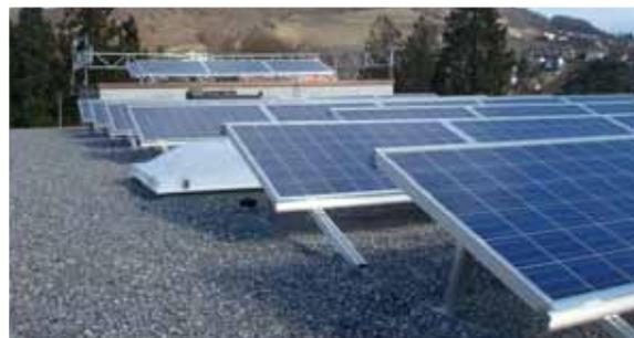
Les trente-six modules solaires convertissent directement le rayonnement solaire en électricité et l'injectent ensuite dans le réseau électrique général.
