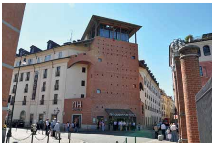
Das Tagungsgebäude – mitten in der Altstadt von Turin
