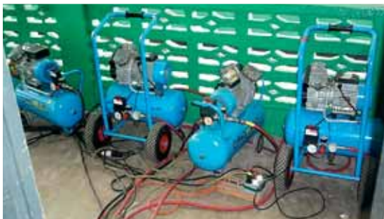
Le navire hôpital est totalement autonome grâce à ses générateurs et ne dépend en rien des infrastructures locales précaires.
