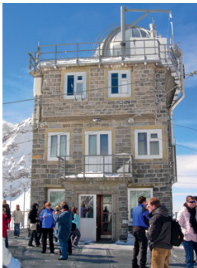
Das Sphinx-Observatorium ist Teil der internationalen Forschungsstation auf dem Jungfraujoch, vorne ein Teil der Aussichtsterrasse.
